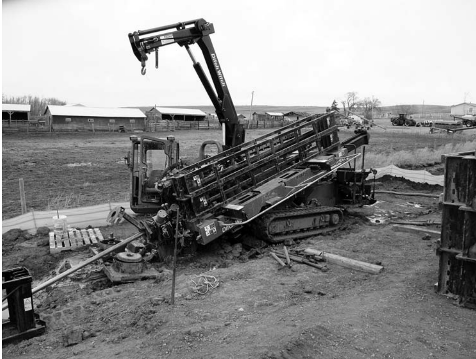
Fig. 13.6 HDD drilling rig.
